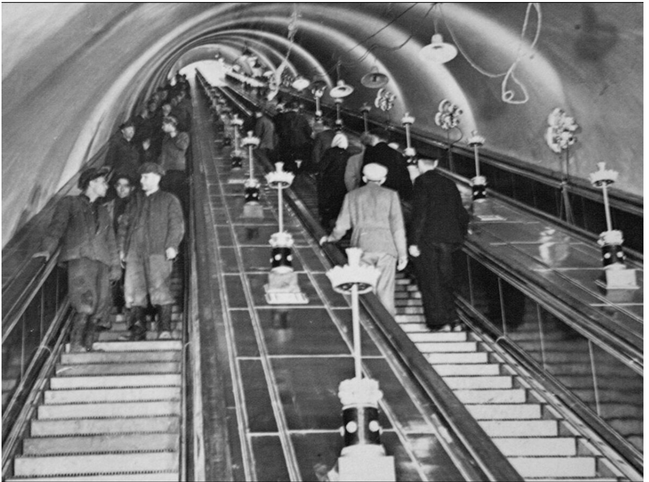
Испытания эскалаторов и монтаж осветительной арматуры на станции "Крещатик" Киевского метрополитена. 1960. Фото опубликовано в блоге Олега Тоцкого URL: https://tov-tob.livejournal.com/78483.html
