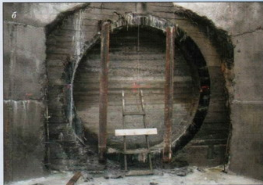
Рис. 3. Стартовая шахта диаметром 9 м (а) и приемная шахта диаметром 6 м (б)
