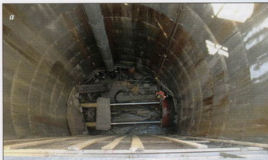
Рис. 3. Стартовая шахта диаметром 9 м (а) и приемная шахта диаметром 6 м (б)
