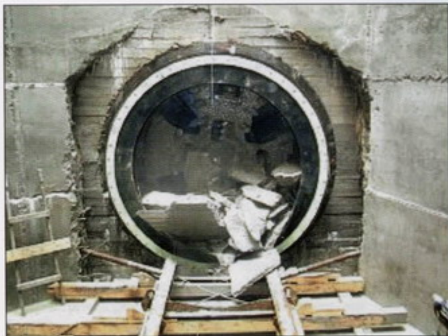
Рис. 4. Радость маркшейдера — сбойка тоннеля
