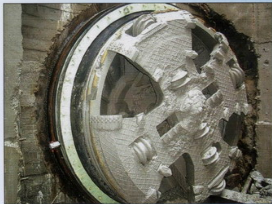
Рис. 5. Отклонение от проектной трассы по горизонтали и вертикали — 5 мм
