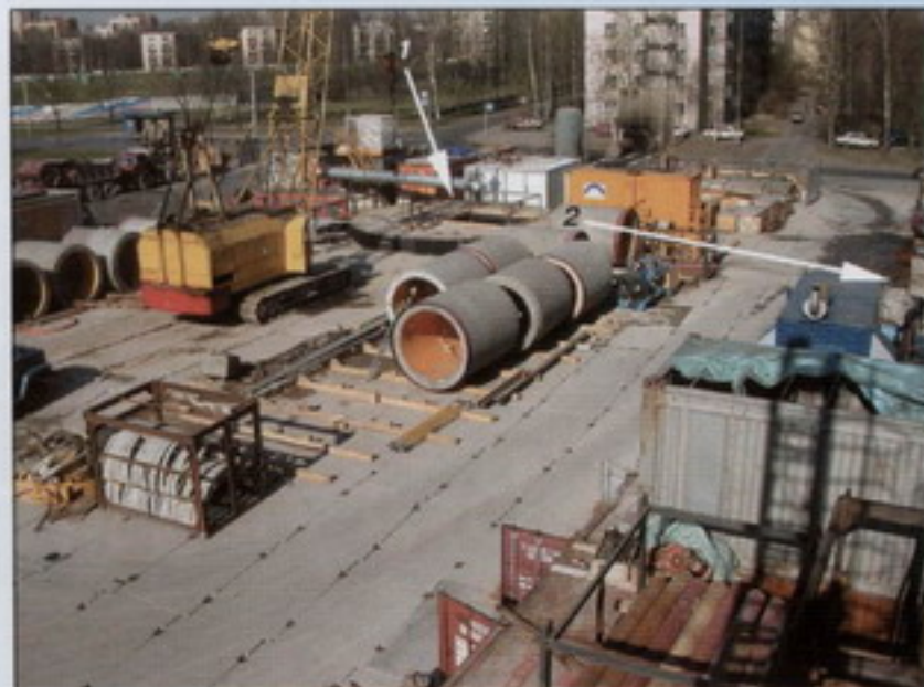
Рис. 1. Строительная площадка со стартовой шахтой и защитным перекрытием:
