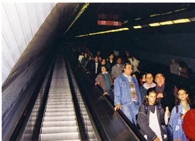
Рис. 2. Будапештский метрополитен. Четыре эскалатора O&K в тоннеле диаметром 7,5 м. В таких тоннелях помещаются только три наши эскалатора (как старых типов — Н, ЭМ, ЛТ, ЭТ, — так и выпускаемых в настоящее время)
